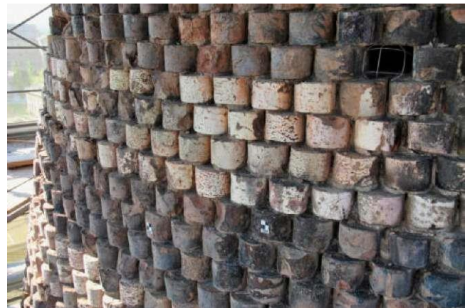
სურ. 2. კონუსური შპილის დეტალი, შესრულებული დიქრომატული მოჭიქური აგურებით: შავი და თეთრი. ქვის წყობაში შეინიშნებადაზიანებები. ზზარები და ეროზია.
