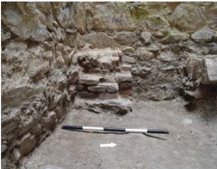
სურათი. 2 სამხრეთ ნაწილში მიშენებული კოშკის გასამაგრებელი კონსტრუქციული ელემენტი
